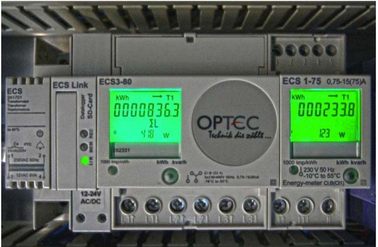
Abbildung 3: Energie- und Leistungsmessgerät mit Datenlogger für SD-Karte
