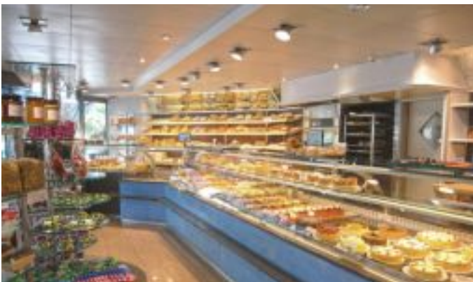
Vorher: Halogenbeleuchtung. (Bild: Stefan Gasser)
